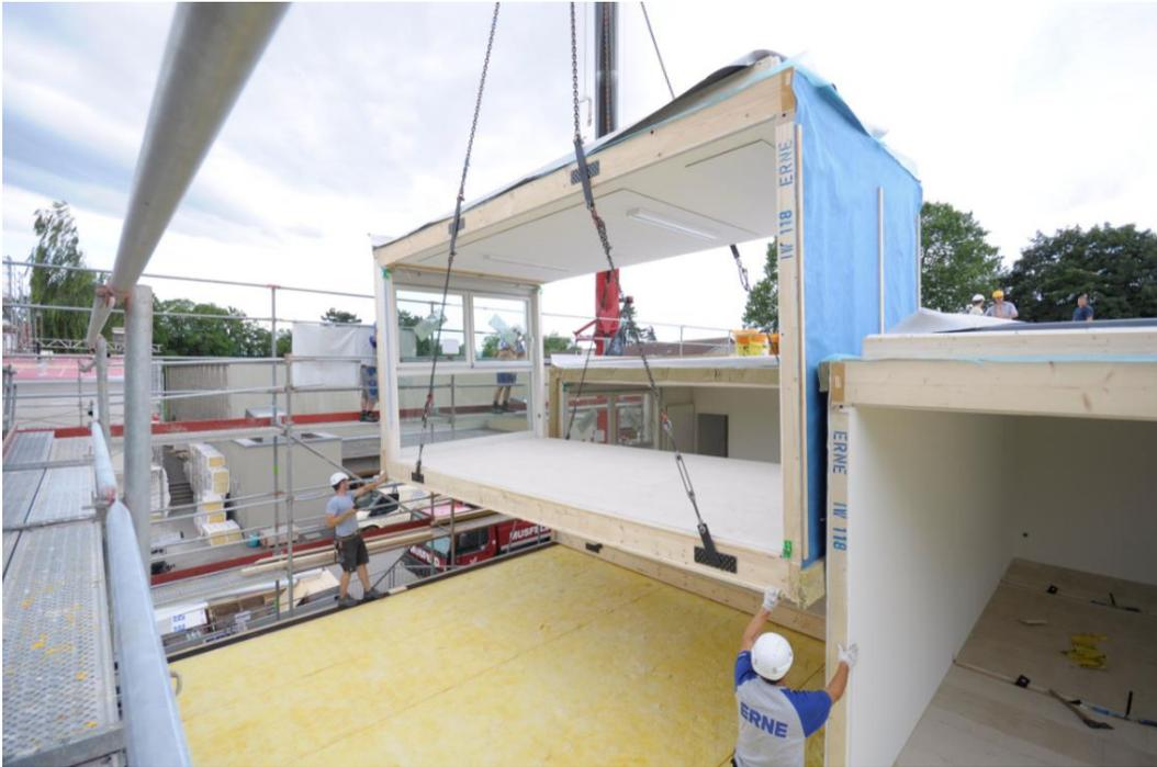
Abb. 11: Basler Modulbau, Montage der Elemente am aktuellen Standort
