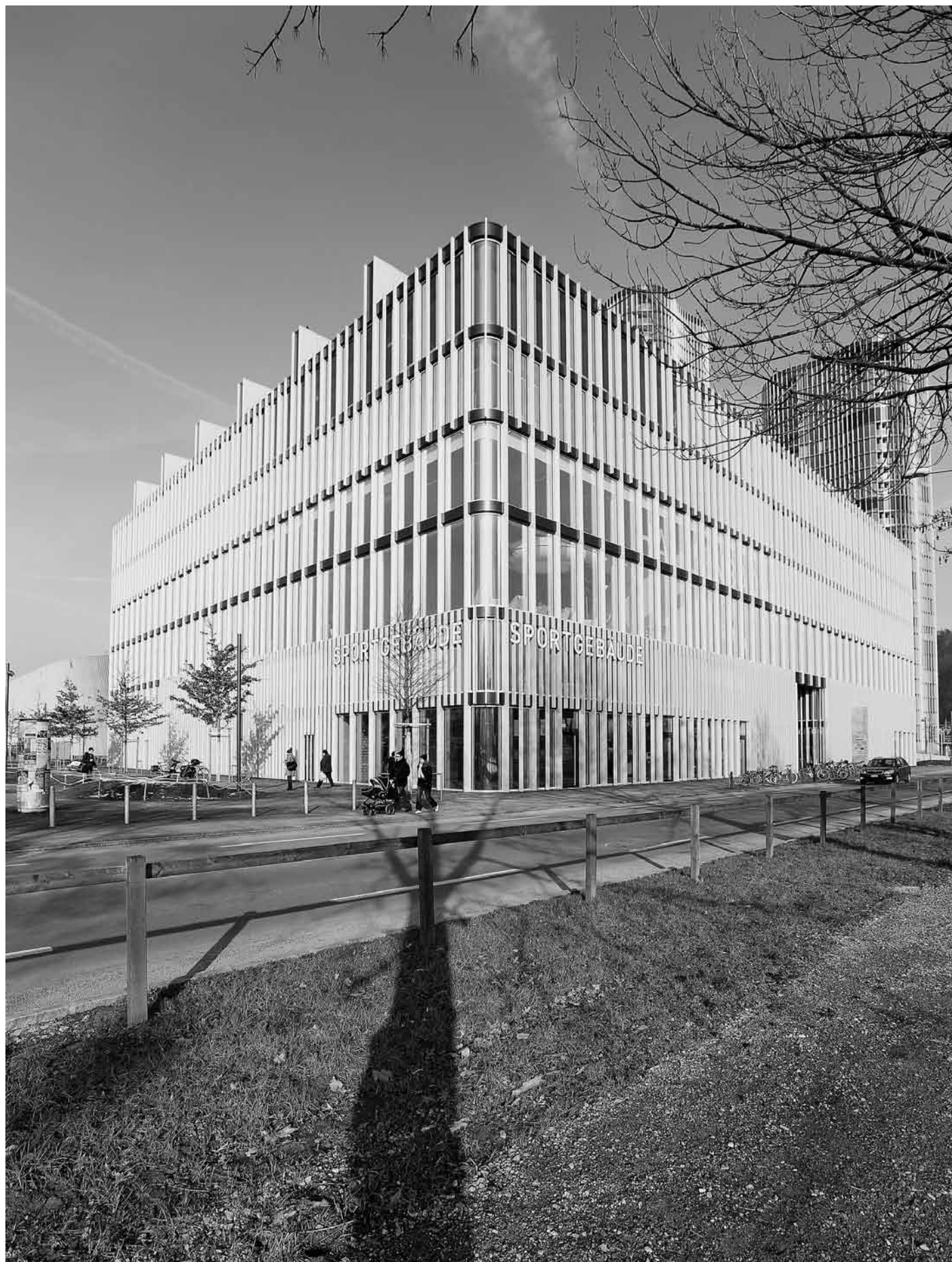
Das Sportgebäude beherbergt Hallenbad, Doppelturnhalle und Fitnesszentrum.
