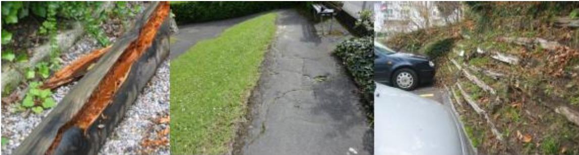
*Beispiele: Faulende Holzpfosten, welche in kurzer Zeit die Statik gefährden und das Sicherheitsrisiko erhöhen. Durchbrechende Beläge, welche Stolpergefahren bergen, oder Stützmauern, die das Ende der Lebensdauer erreicht haben.*
