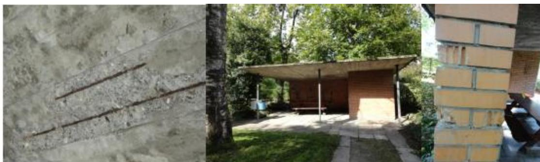
*Beispiel 2: Korrosionsschäden und sich senkende Stützen. Diese führen bei einem Unterstand zu Instabilität und Einsturzgefahr.*
