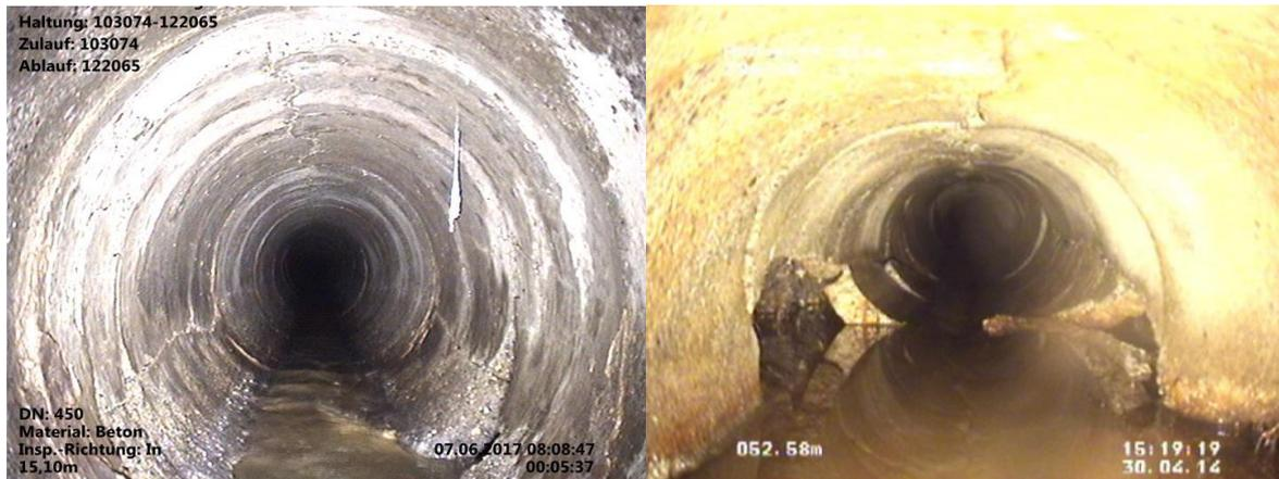
Links: Zustands- und Dringlichkeitsstufe 1 erkennbar an den Längsrissen im Scheitel und an beiden Seiten entlang eines ganzen Rohres und der bereits stark ausgewaschenen Sohle, aus der die Körnung des Betons hervortritt. Rechts: Zustands- und Dringlichkeitsstufe 0 erkennbar an der ovalen Deformation des normalerweise kreisrunden Profils und den Scherben.
