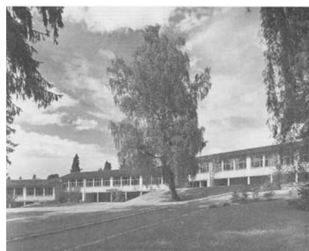
Luzern: Architekt: Pavillonschule Felsberg, 1948 Emil Jauch, Luzern
