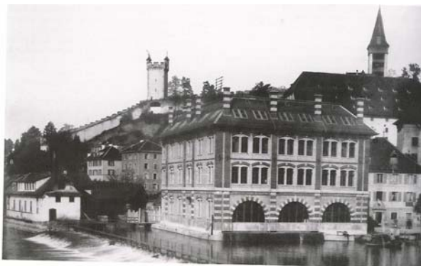
1901: Blick von Süden auf das Gewerbegebäude
